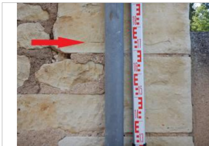
Vue du repère - Auteur : SPC LACI
