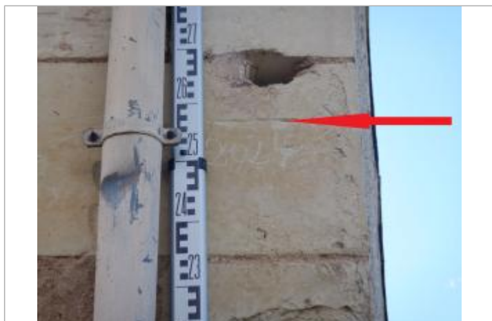
Vue du repère - Auteur : SPC LACI
