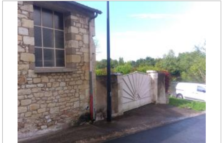
Vue du site - Auteur : SPC LACI
