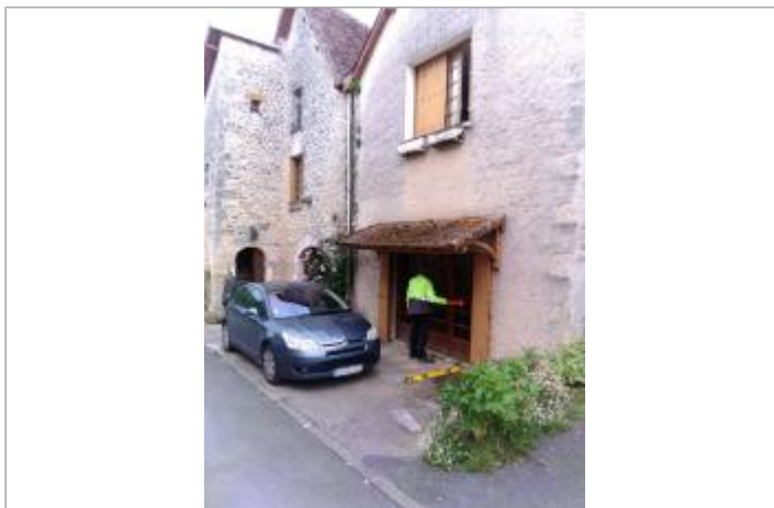
Vue du site - Auteur : SPC LACI
