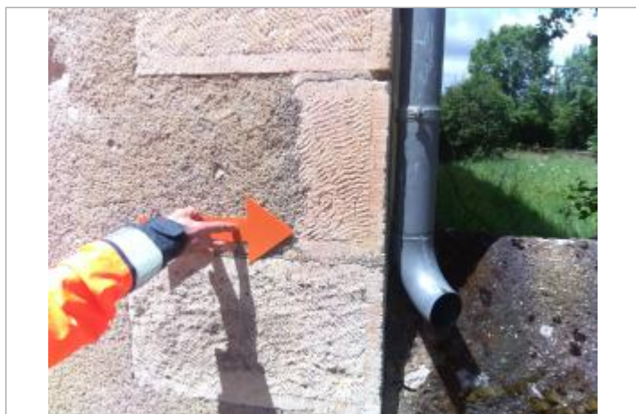
Vue du repère - Auteur : SPC LACI
