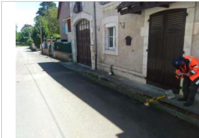
Vue du site - Auteur : SPC LACI
