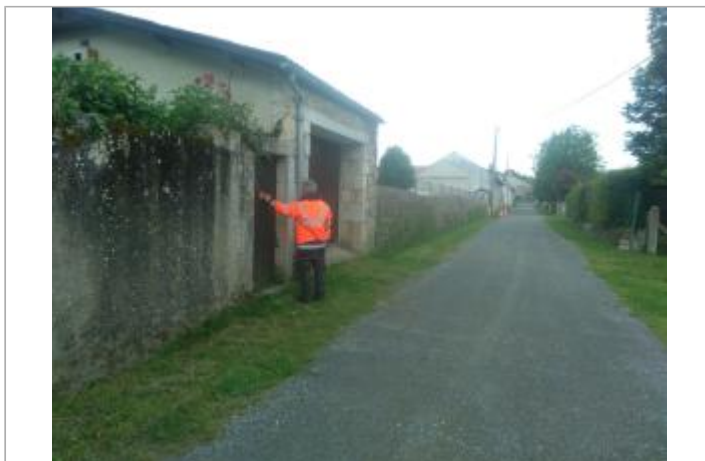
Vue du site - Auteur : SPC LACI
