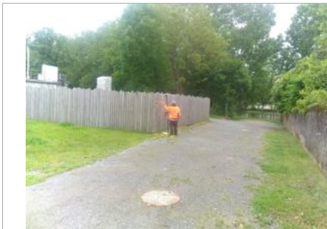
Vue du site - Auteur : SPC LACI
