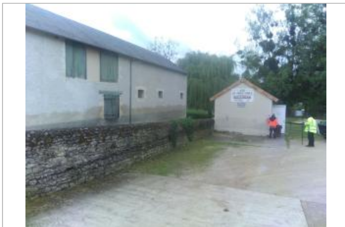
Vue du site - Auteur : SPC LACI
