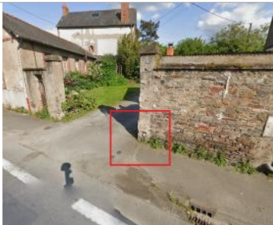
Pilier au 33 rue de Vannes
