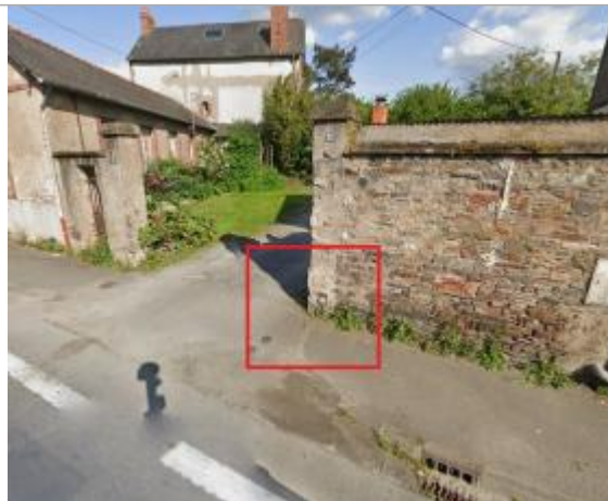
Pilier au 33 rue de Vannes
