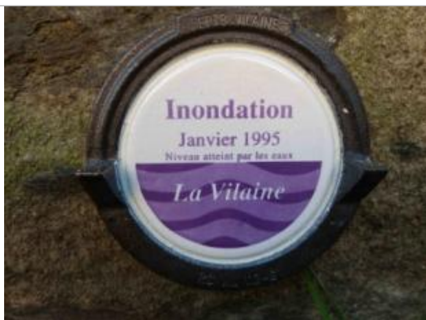
Repère normalisé de la crue de janvier 1995
