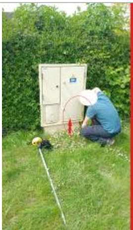
laisse de crue à 35 cm/sol.
