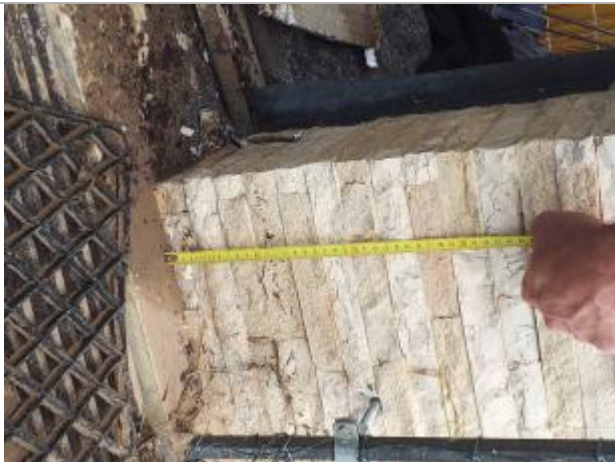
11 cm par rapport au seuil de la porte de garage
