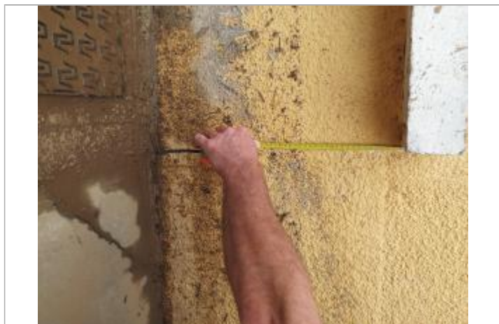
26 cm sous la tablette de la 2ème fenêtre à droite de la porte d'entrée
