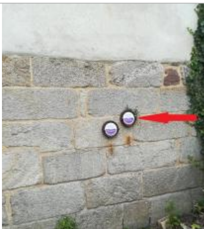
Repère normalisé de la crue de janvier 1995
