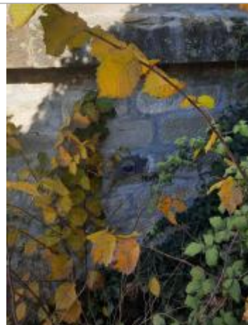
Vue du site, auteur : SMMAR, 2024
