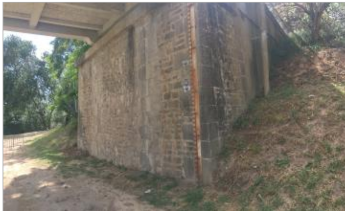
Vue du site - Auteur : CACG
