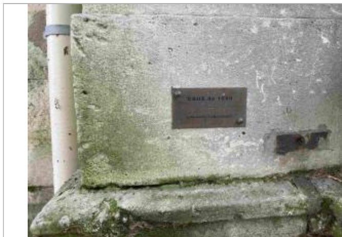
Repère de crue. "Crue de 1910 - (plus hautes eaux connues)"
