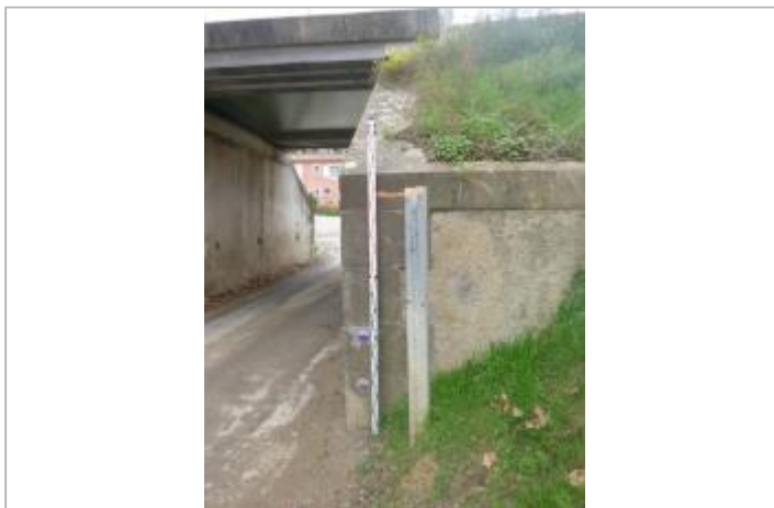
Berge rive droite - Photo ©AGERIN
