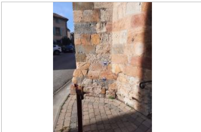
vue de l'église avec les différents repères
