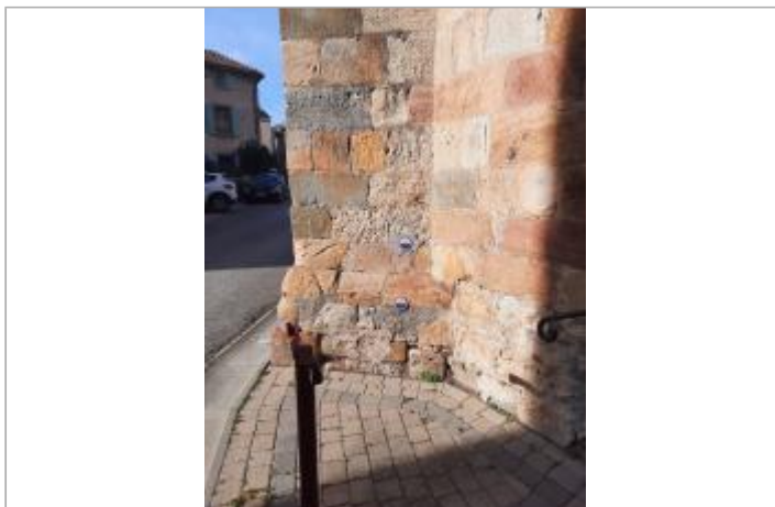
vue de l'église avec les différents repères
