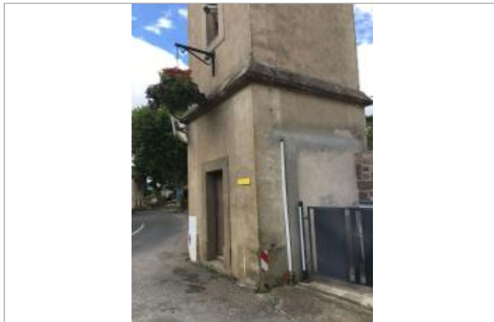
Vue du site, auteur : SMMAR, 2024
