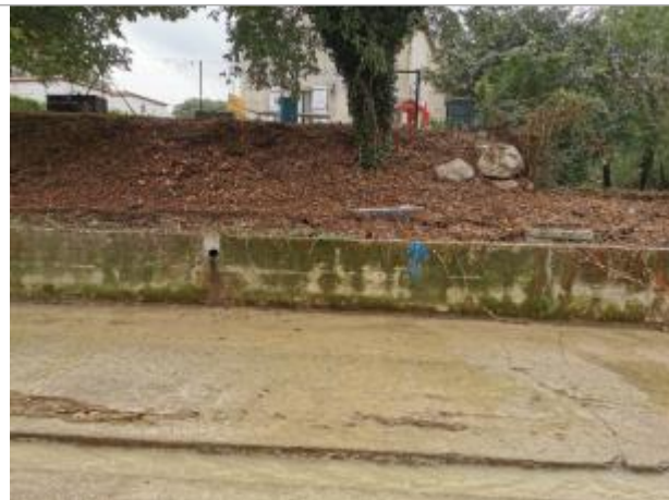
Vue du site, auteur: OTEIS, 2023
