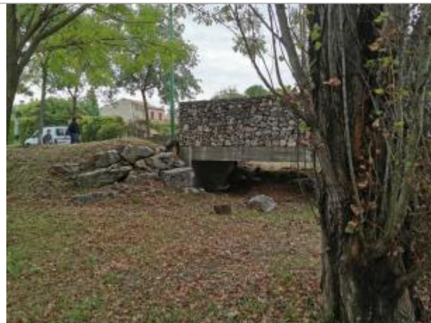
Vue du site, auteur: OTEIS, 2023
