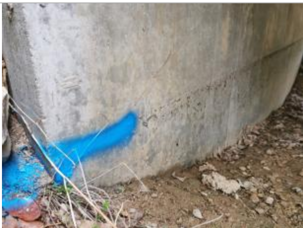
Vue du repère, auteur: OTEIS, 2023
