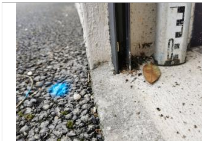
Vue du repère, auteur: OTEIS, 2023
