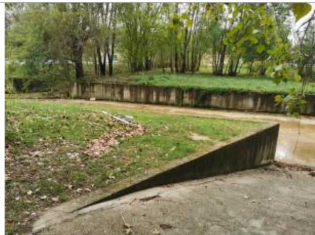
Vue du site, auteur: OTEIS, 2023
