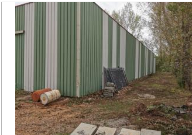
Vue du site, auteur: OTEIS, 2023
