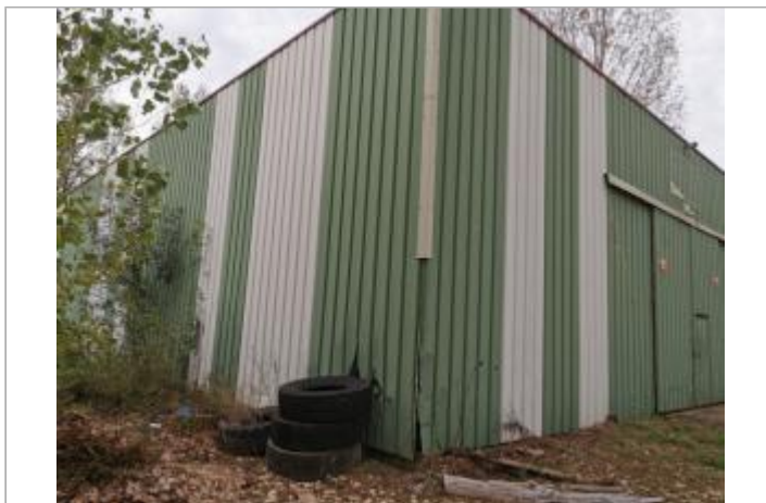
Vue du site, auteur: OTEIS, 2023
