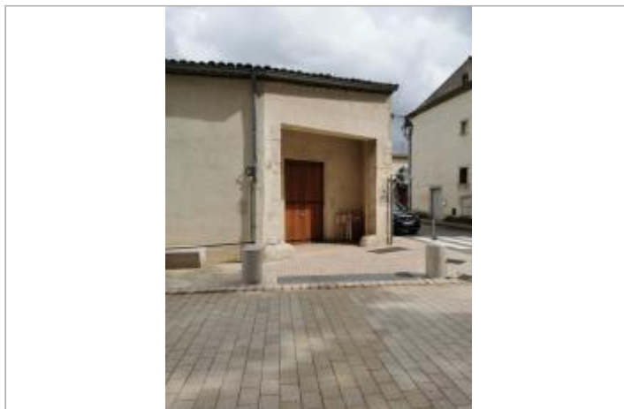
Vue du site, auteur: OTEIS, 2023
