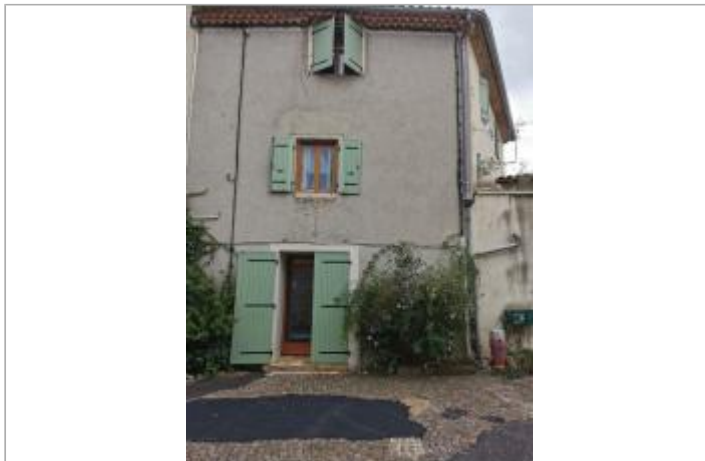
Vue du site, auteur: OTEIS, 2023
