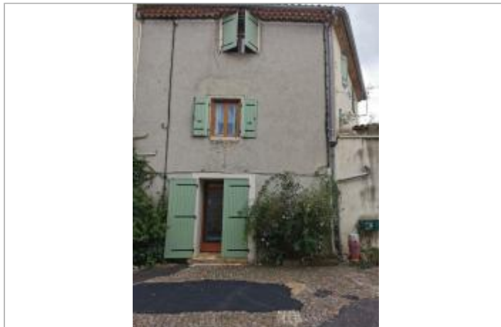
Vue du site, auteur: OTEIS, 2023
