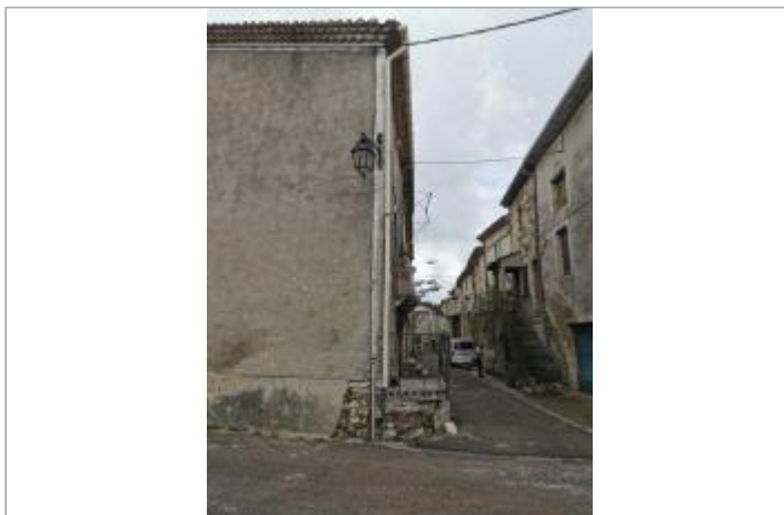
Vue du site, auteur: OTEIS, 2023
