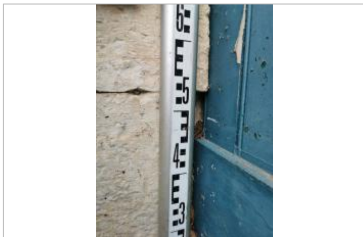
Vue du repère, auteur: OTEIS, 2023
