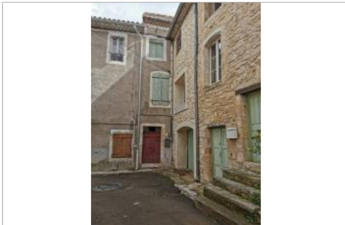
Vue du site, auteur: OTEIS, 2023
