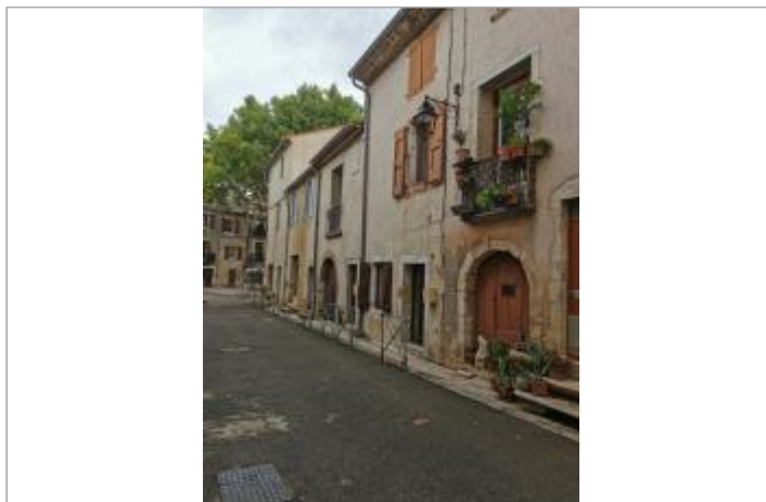
Vue du site, auteur: OTEIS, 2023
