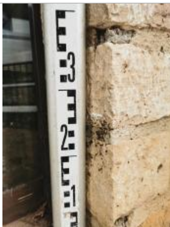
Vue du repère, auteur: OTEIS, 2023
