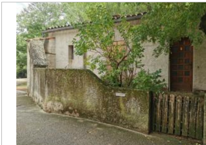
Vue du site, auteur: OTEIS, 2023
