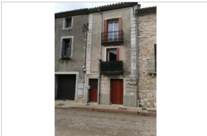
Vue du site, auteur: OTEIS, 2023
