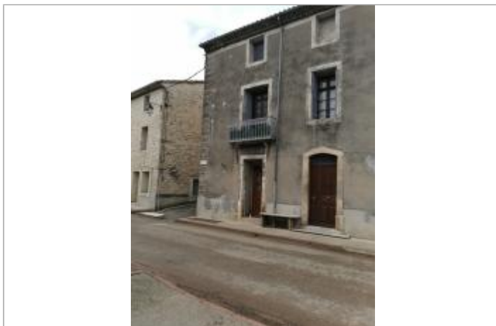
Vue du site, auteur: OTEIS, 2023
