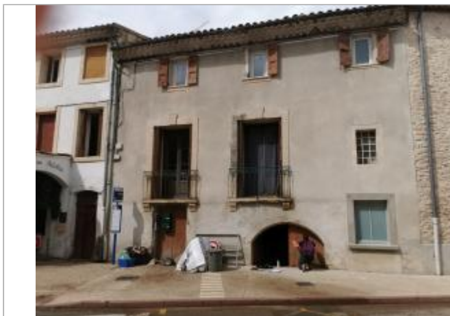
Vue du site, auteur: OTEIS, 2023
