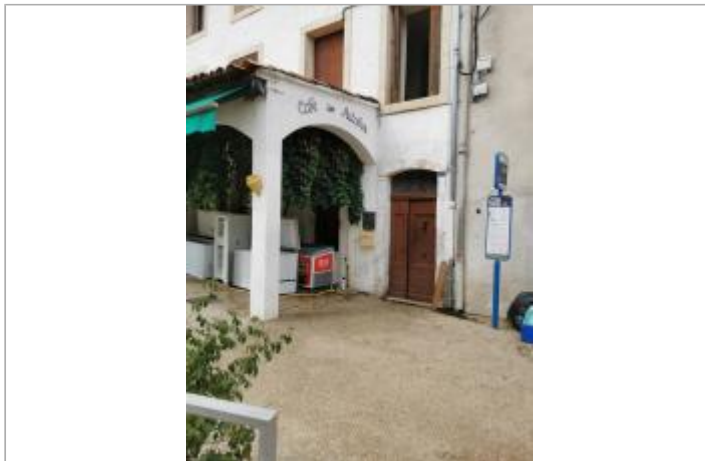
Vue du site, auteur: OTEIS, 2023
