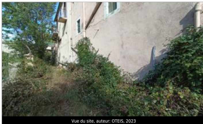
Vue du site, auteur: OTEIS, 2023
