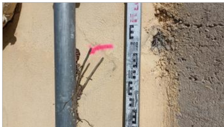
Vue du repère, auteur: OTEIS, 2023
