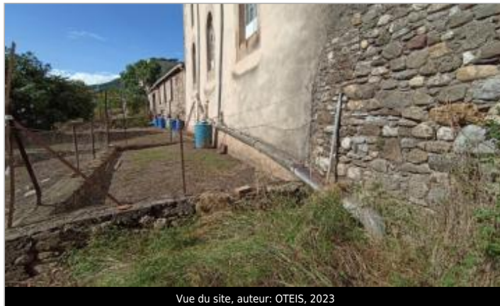
Vue du site, auteur: OTEIS, 2023
