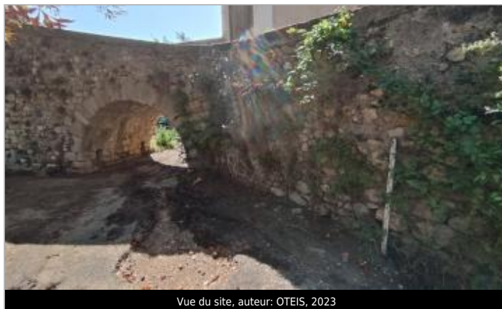
Vue du site, auteur: OTEIS, 2023
