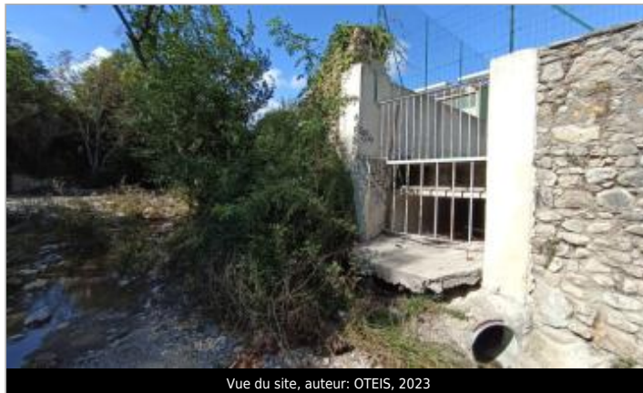
Vue du site, auteur: OTEIS, 2023
