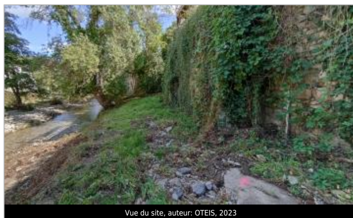
Vue du site, auteur: OTEIS, 2023
