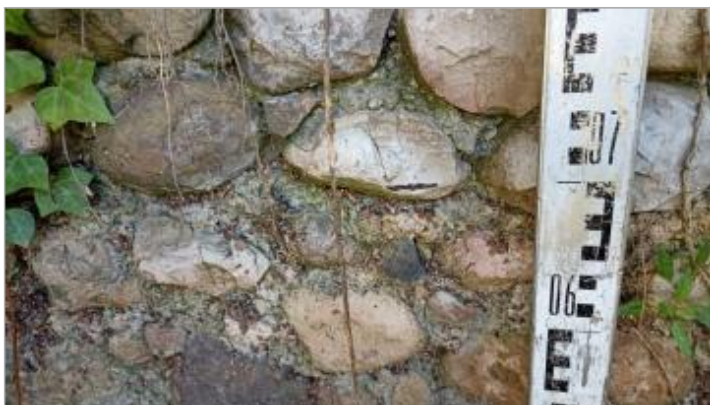
Vue du repère, auteur: OTEIS, 2023
