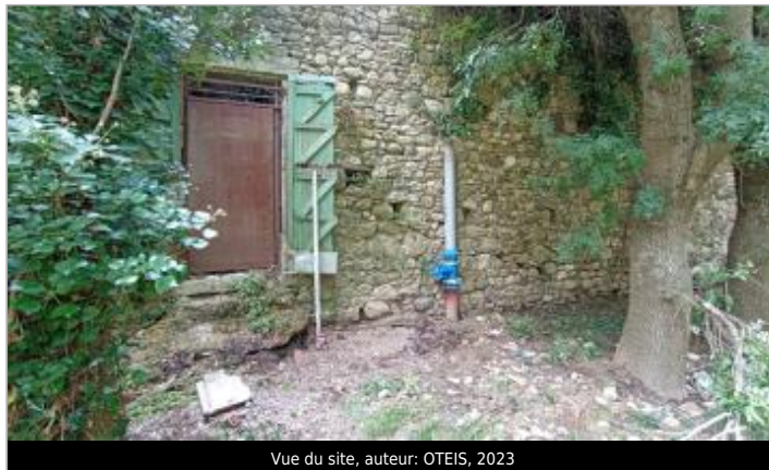
Vue du site, auteur: OTEIS, 2023
