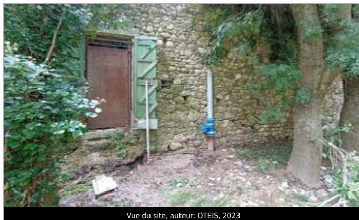
Vue du site, auteur: OTEIS, 2023
