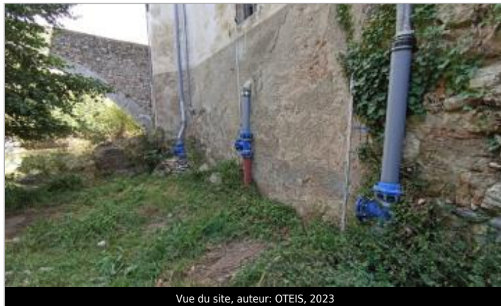
Vue du site, auteur: OTEIS, 2023
