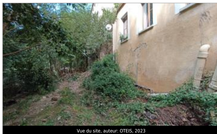
Vue du site, auteur: OTEIS, 2023
