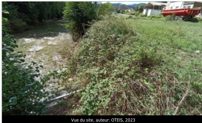
Vue du site, auteur: OTEIS, 2023
