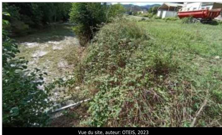
Vue du site, auteur: OTEIS, 2023
