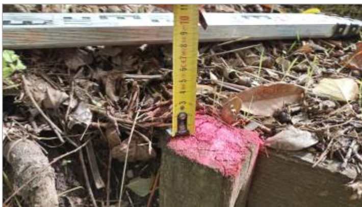
Vue du repère, auteur: OTEIS, 2023
