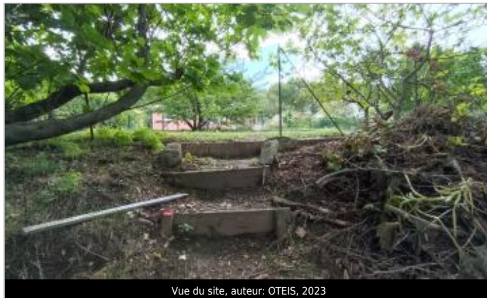
Vue du site, auteur: OTEIS, 2023
