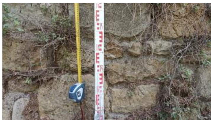
Vue du repère, auteur: OTEIS, 2023
