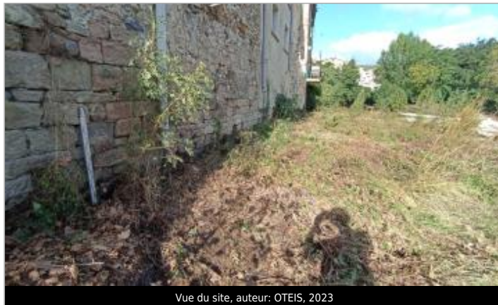
Vue du site, auteur: OTEIS, 2023
