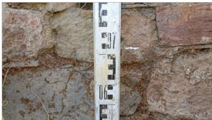
Vue du repère, auteur: OTEIS, 2023
